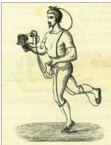
Rys. 1.19. Pomiar siły w czasie ruchu człowieka i konia
